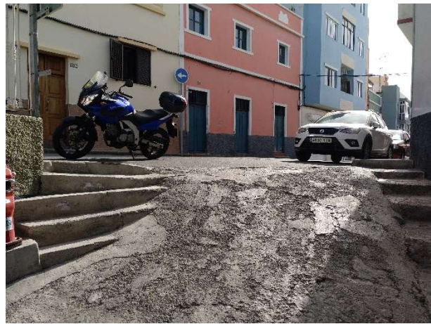
Acceso a Rampa Calle San Felipe
