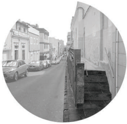
Falta de acerado
