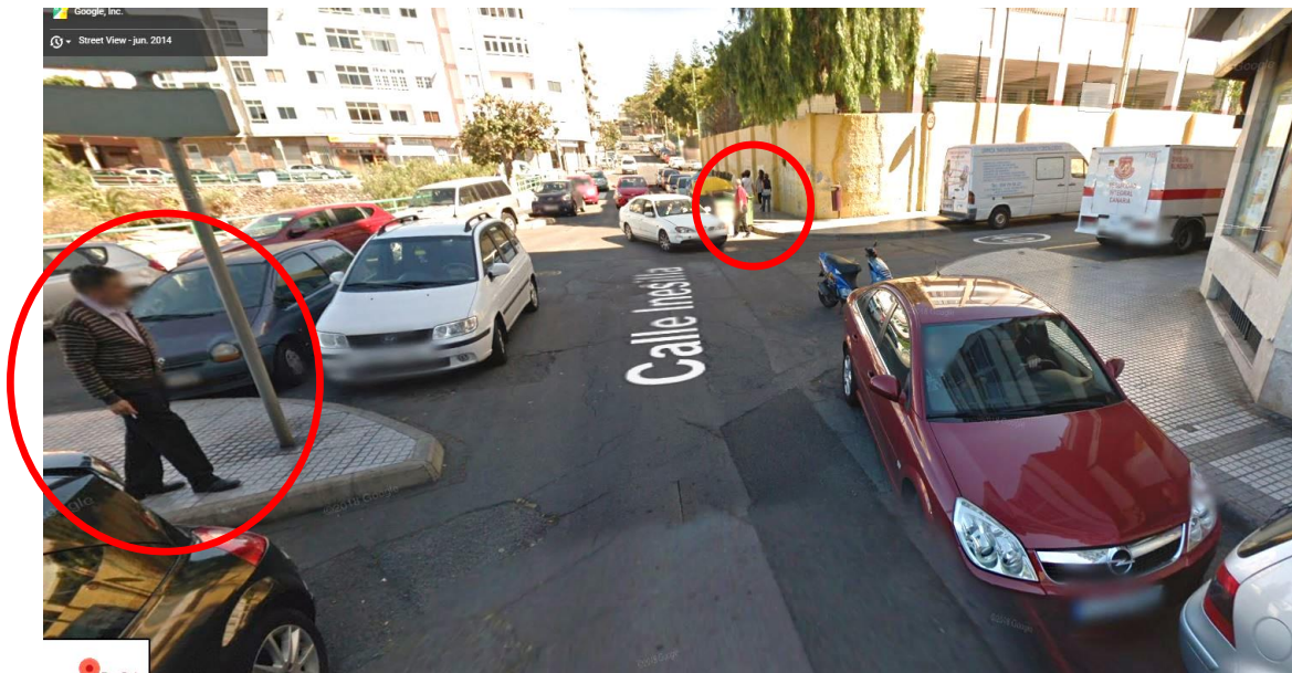
Imagen 4- Cruce C/Inesilla (Vía principal) con C/Sor Simona existencia de barreras arquitectónicas y ausencia de paso peatonal. Estacionamiento de vehículos en cruce dejando poca visibilidad para peatones.
