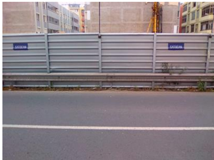
Parte sin aceras en la Calle República Dominicana
