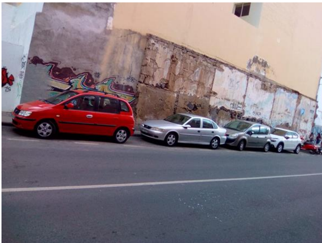
Aceras estrechas en Calle República Dominicana
